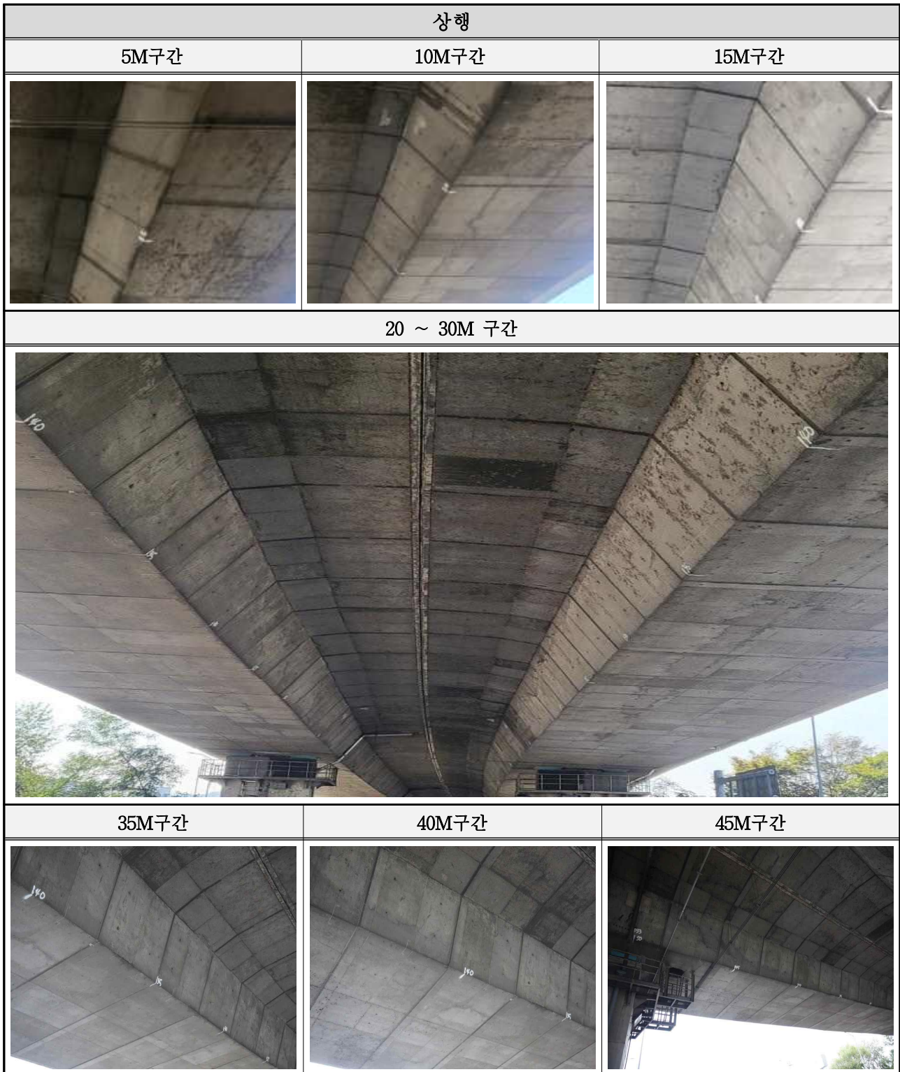
【사진 3.4.6】 거더외부(상행) 외관조사 관련사진
